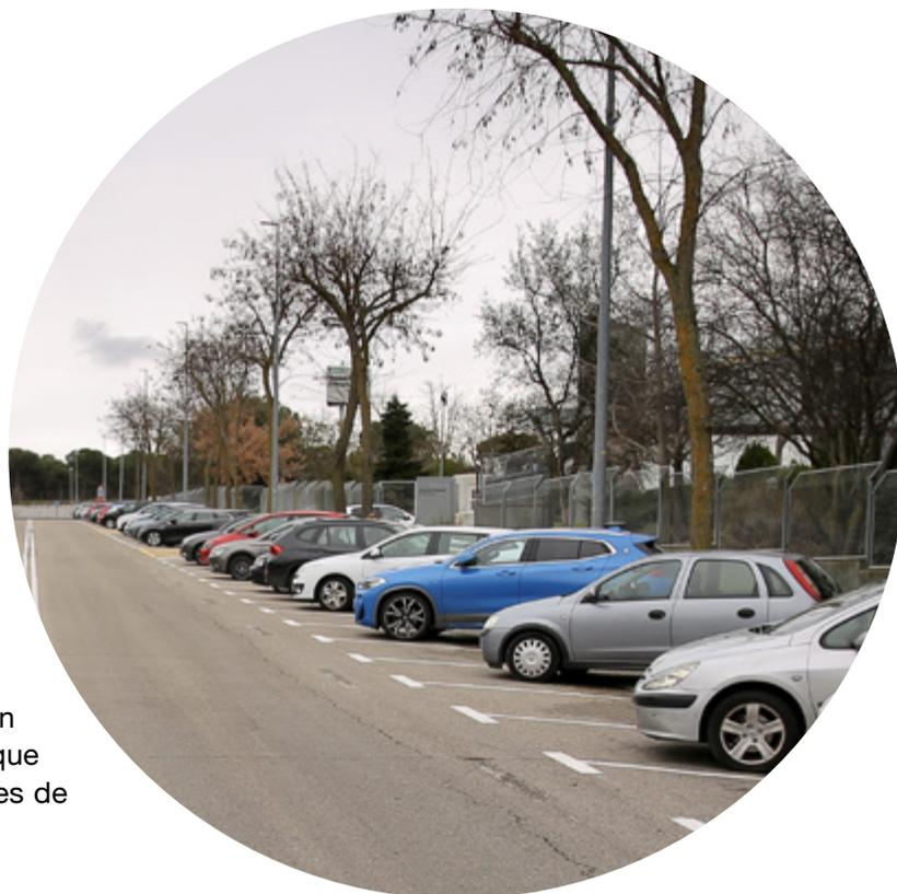
La mayor parte de las nuevas plazas se obtienen del cambio de tipología de aparcamiento en línea a aparcamiento en batería de tipo “espiga”, pensado para aparcar marcha atrás mejorando la seguridad tanto en la maniobra de aparcamiento como en la hora de acceder al maletero –que queda así junto a la acera-. También supone una mejora en la protección de pasajeros y niños, que al abrir la puerta se conducen de forma natural hacia la acera.
